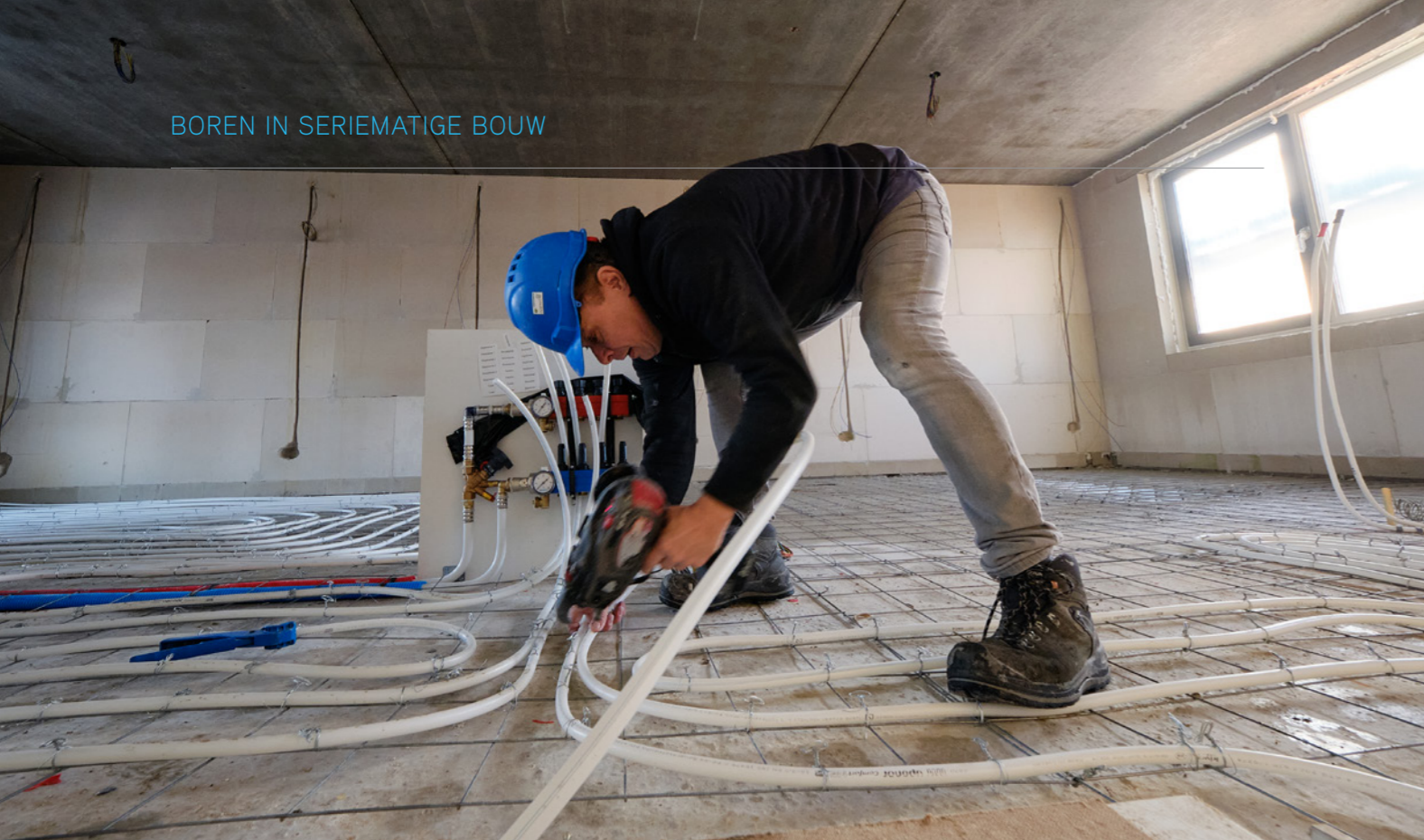
Aanleg van vloerverwarming door Heating Service in één van de woningen
