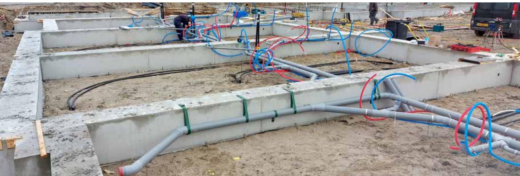
Prefab werken bespaart tijd op de bouwplaats.
