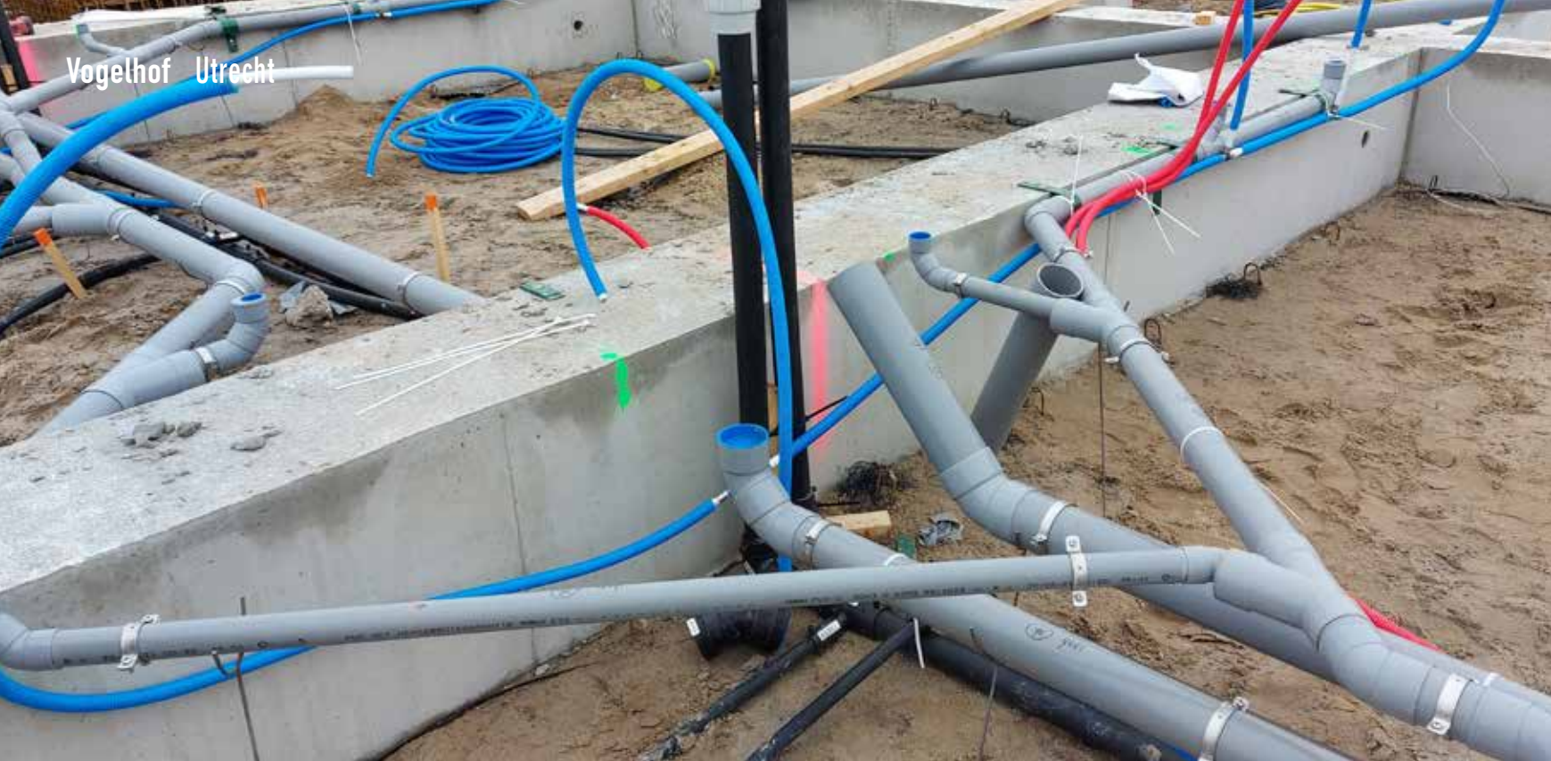
Heating Service plaatste de binnenriolering, waterleidingen, hemelwaterafvoer, badkamers en toiletten.
